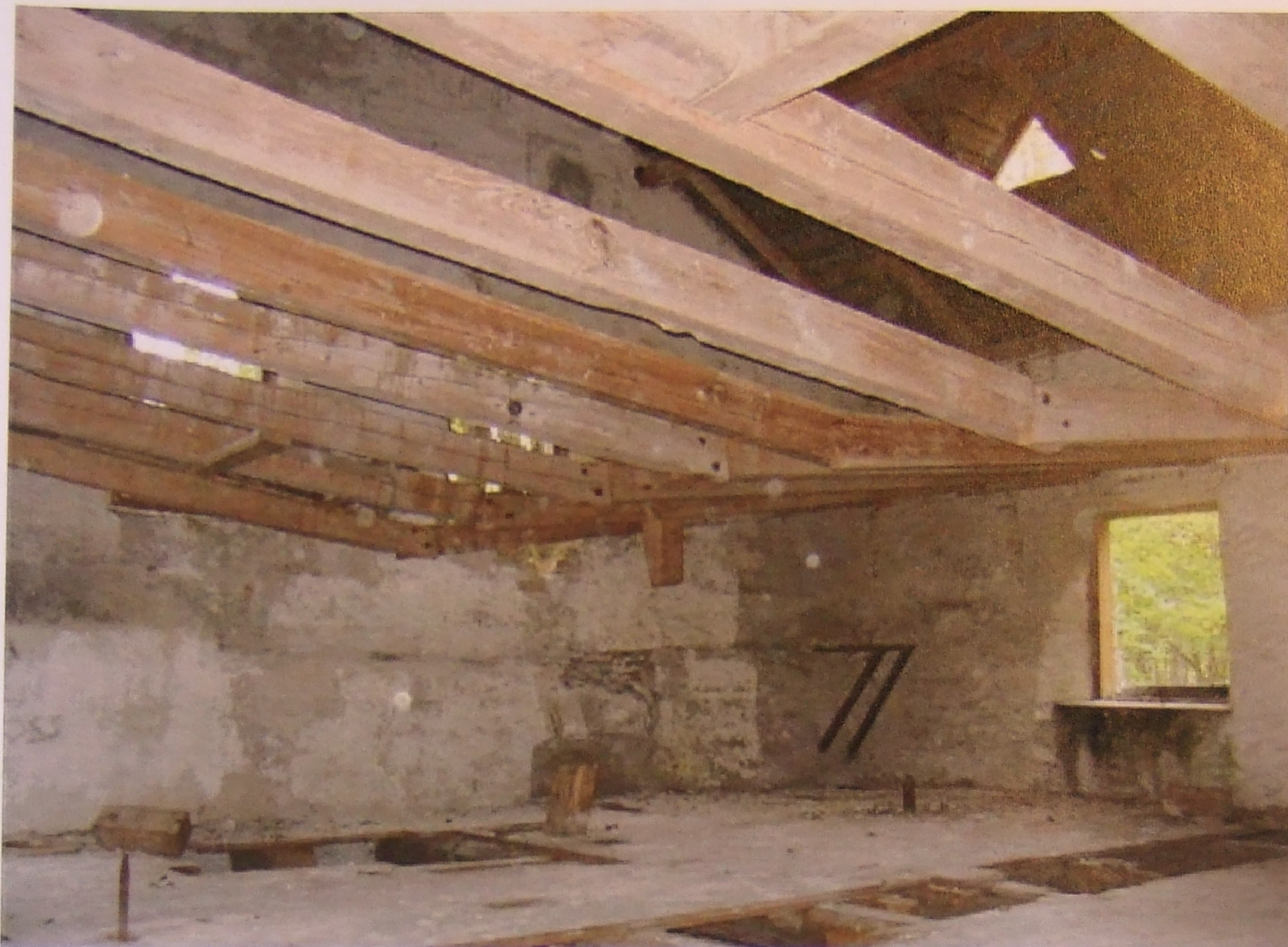
FOTO 7: Masinasaali avriiohtlikult läbivajunud vahelagi vahelagi.
