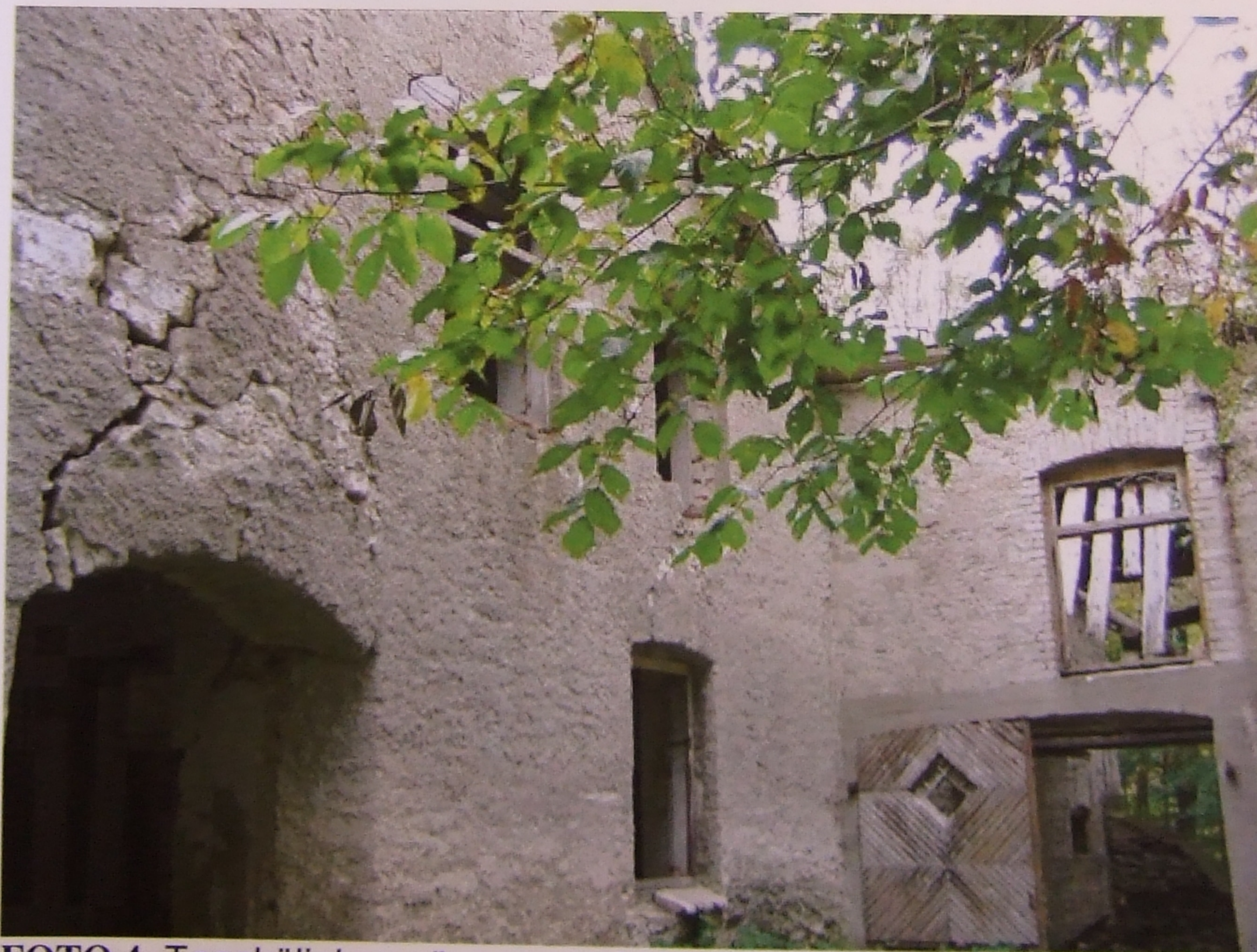
FOTO 4: Tagaküljel on väga suured ning avariohtlikud kaldpraod.
